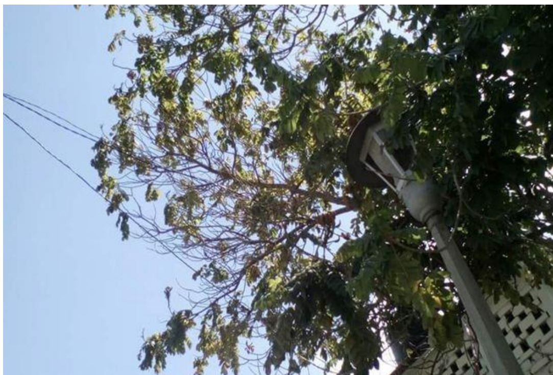
Fig. 2- Conflicto con el tendido eléctrico
